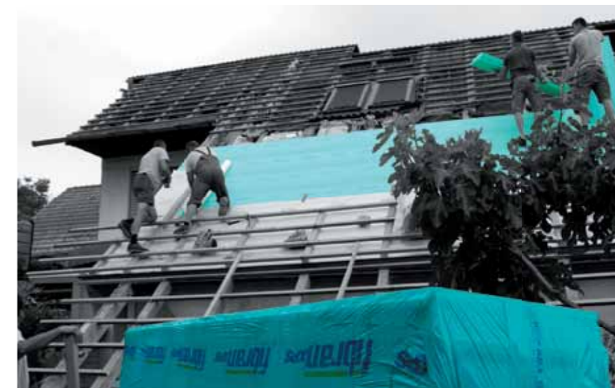
Energetski najučinkovitije sustavno rješenje za sanaciju kosog krova stambenog potkrovlja je kombinacija reflektirajuće sekundarne membrane FIBRANskin VENT SILVER i toplinske izolacije FIBRANxps MAESTRO
