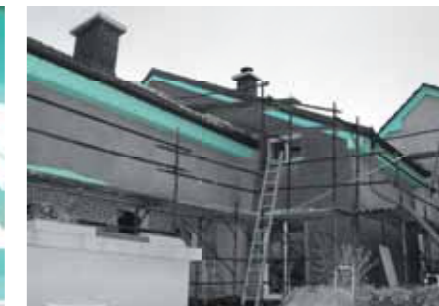
Krovni istaci izvedeni FIBRANxps ETICS pločama. Debljina ovisi o rasponu konstrukcije.
