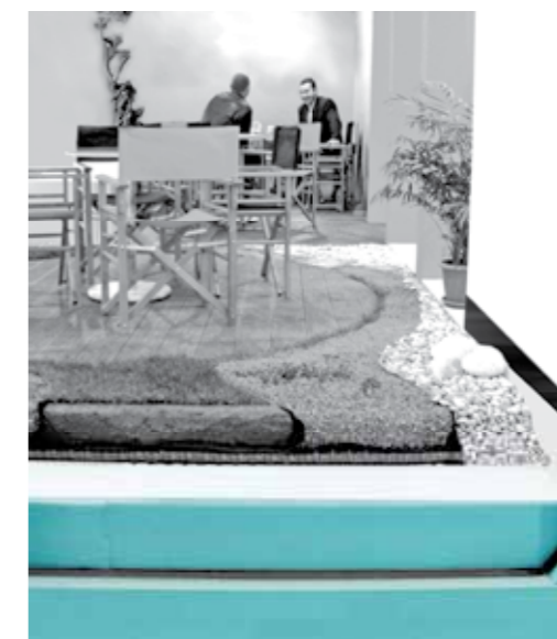
OPTIMO SKIN SEAL krov s FIBRANxps INCLINE i FIBRANskin SEAL (membranom, koja pospješeno odvodnjom omogućuje krovu dodatnu toplinsku učinkovitost)
