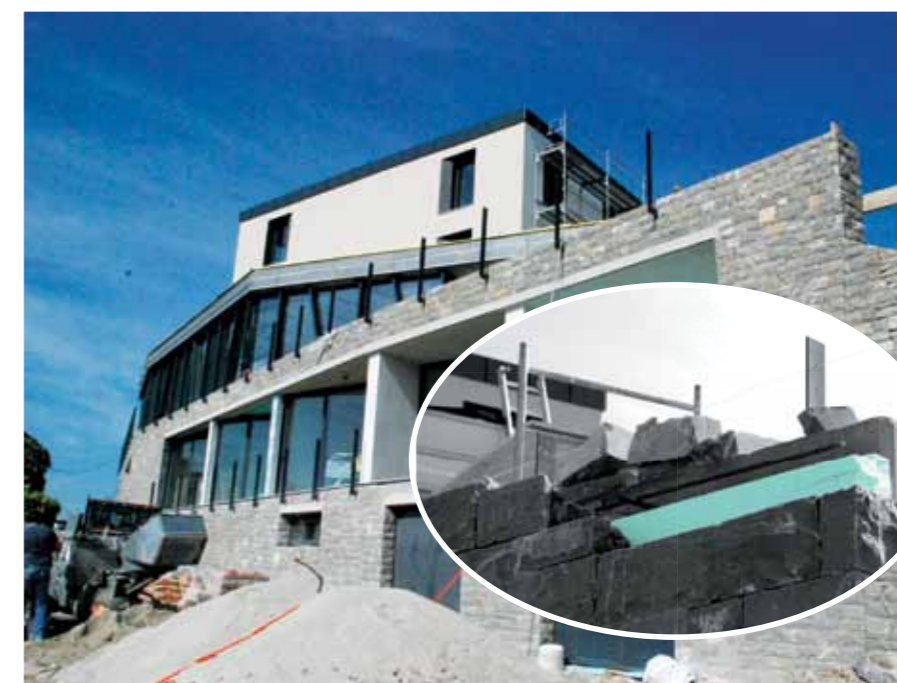
Kamena fasada hotelskog objekta, izolirana nosivom izolacijom FIBRANxps ETICS BT, na koju je posebnim postupkom zalijepljen prirodni kameni
