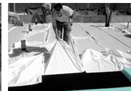
Postupno uklanjamo zaštitnu foliju dvostrano ljepljive hidroizolacije FIBRANhydro SEISMIC T-1,8 sk/sk.
