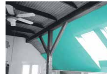
Izvedba unutarnje toplinske izolacije FIBRANxps ETICS pločama koje površinski zaštitimo slojem tankoslojne fasade s premazom
