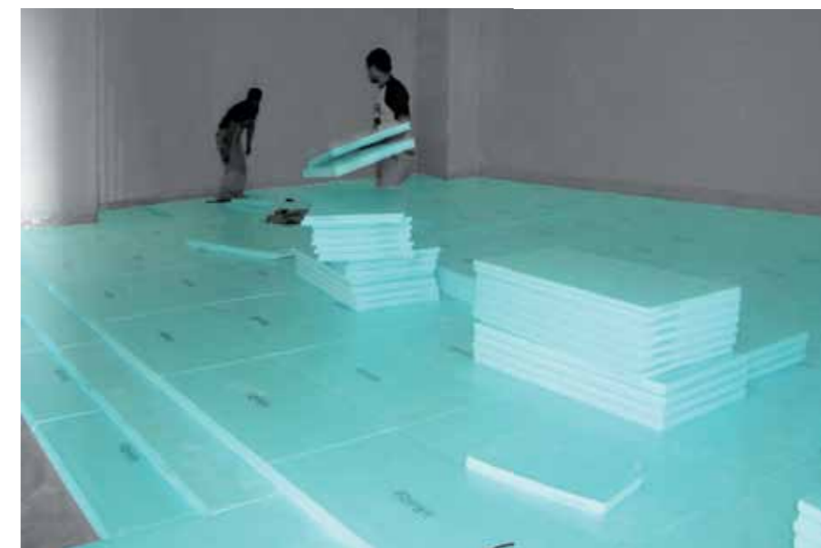
Toplinsko-izolacijske ploče FIBRANxps 300-I s ravnim rubom, namijenjene su upotrebi u višeslojnim sustavima.
