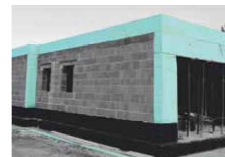
Izolacija toplinskih mostova protupotresnih serklaža i nadvoja FIBRANxps ETICS pločama
