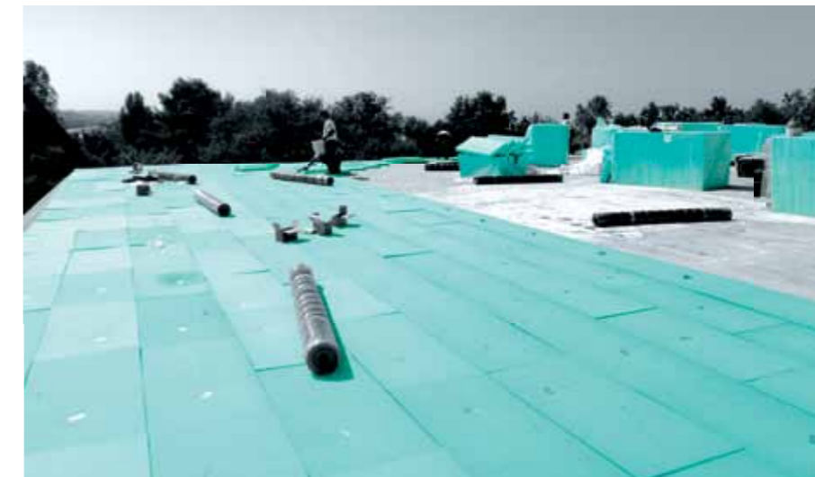
Povećanje krovnog nagiba objekta FIBRANxps INCLINE pločama i istovremeno toplinska sanacija ravnog krova
