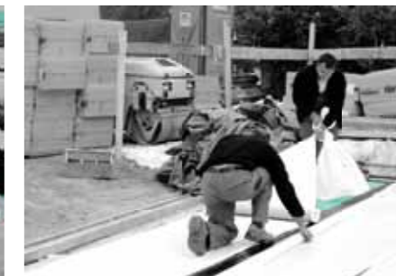
Na precizno položen prvi sloj toplinske izolacije FIBRANxps odgovarajuće debljine i čvrstoće, zalijepimo dvostrano samoljepljivu hidroizolaciju FIBRANhydro SEISMIC T-1,8sk/sk.
