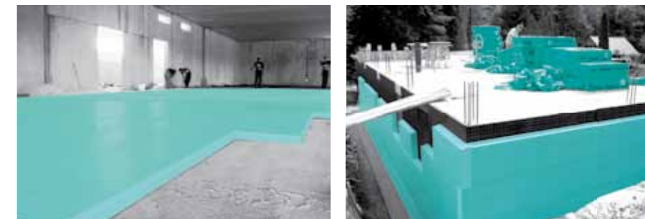
Toplinska izolacija poda u skladišnom objektu FIBRANxps 300-L pločama
